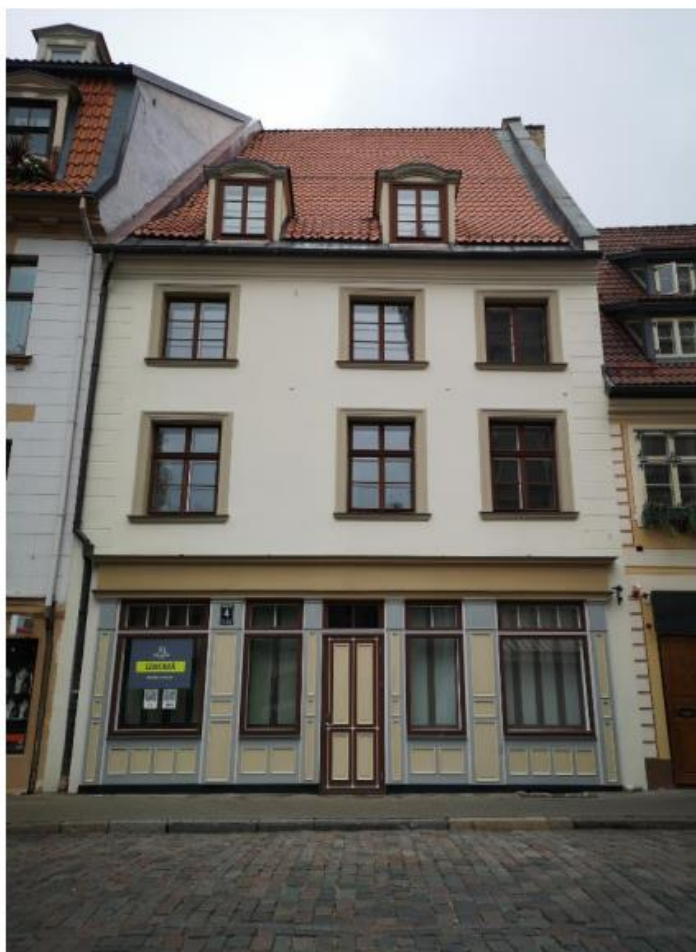
1. attēls. Administratīva ēka Skārņu ielā 4, Rīgā
